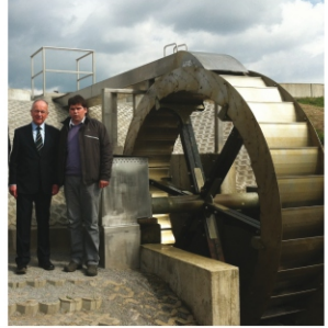
Klärwerk Hillersleben Durchmesser: 3,40 m Breite: 1,50 m Leistung: 3 kW
